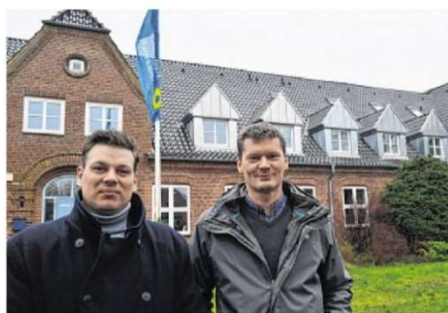
Hat alles gut geklappt: Kreis-Liegenschaftsverwalter Brar Hassold und der Leiter der Nordsee-Akademie, Aaron Jessen (l.) vor dem mit neuen Gauben ausgestatteten Gebäude. FOTOS: ARNDT PRENZEL
