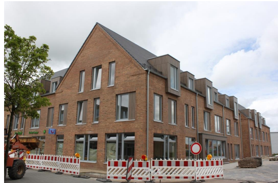
Außenansicht Seniorenwohnanlage mit Tondern-Treff im rechten Erdgeschoss
