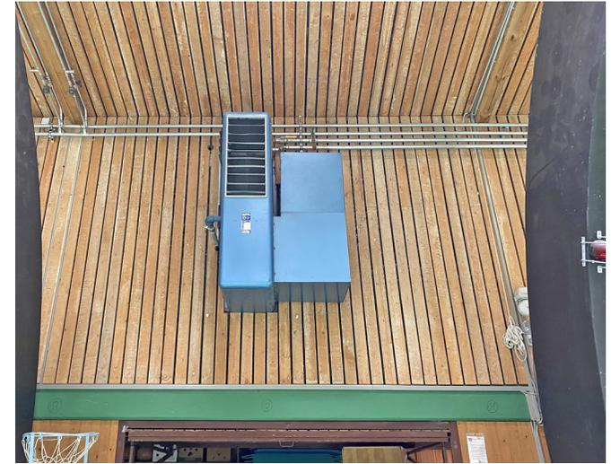
Bauzeitliches Lüftungsgerät. Auch die Temperierung der Halle erfolgt über die Lüftung.
