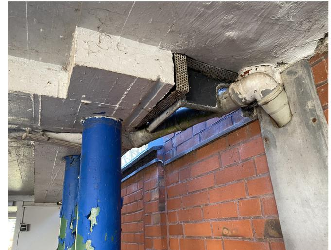
Die Dachentwässerung ist unvorteilhaft gelöst und weist deutliche Altersspuren auf.
