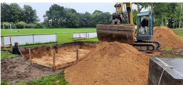
Baustart für die gespielte Sporttribüne des TSV DAB in Drelsdorf (Foto: Gemeinde Drelsdorf).
