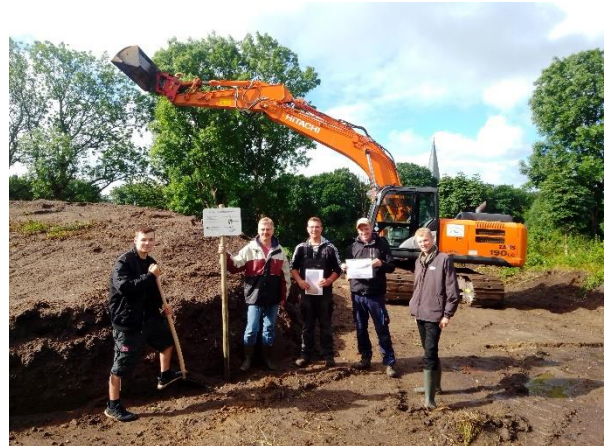
Spatenstich für die neue BMX-Bahn in Breklum v.l. mit Bürgermeister Lass, Mitarbeiter/ Baggerfahrer der Fa. Otto, Struckum, Initiator Lutz Metzner (Foto: C. Lass).
